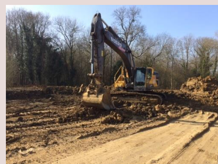
Photos prises depuis le chantier
